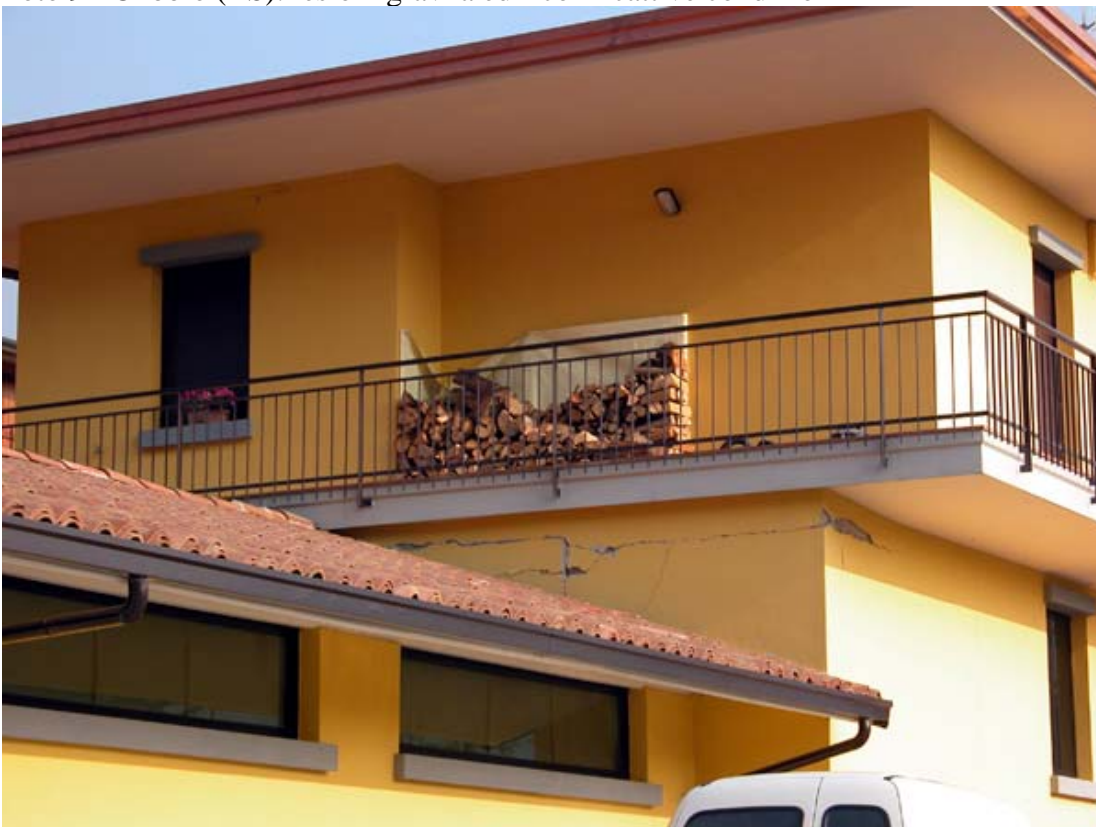
Foto 10 - Pompegnino (BS): lesione passante a livello del solaio
